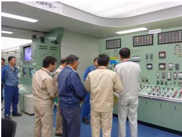
9月18日(土) 非常用炉心冷却系表示灯不具合の改善状況の確認(中央制御室)
