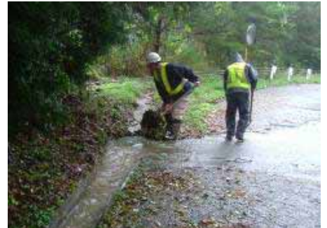
側溝清掃作業
