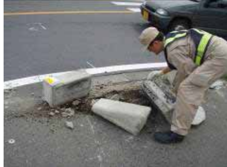
縁石補修作業
