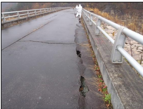
((左) 大柿ダム堤体天端被災箇所、(右) 堤体遠景 (H23.11.30))
