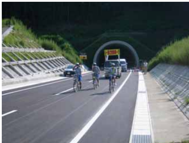
朝日トンネル起点側
