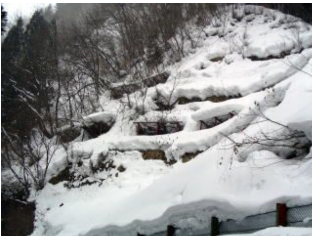
斜面の雪が道路に迫り出している様子 (大沼郡金山町内 平成18年1月撮影)
