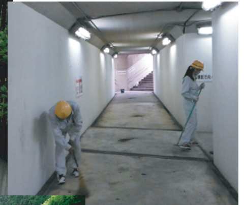
地下道の点検・清掃
