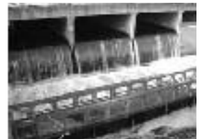
森ヶ崎水再生センター
