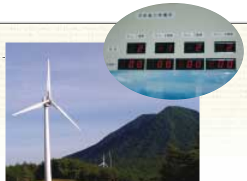
二岐山の天栄風力発電所
