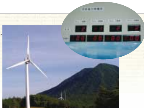
二岐山の天栄風力発電所
