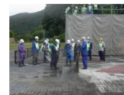
除染作業の様子
