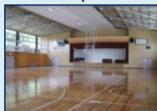
災害復旧事業 (県立高校体育館)
