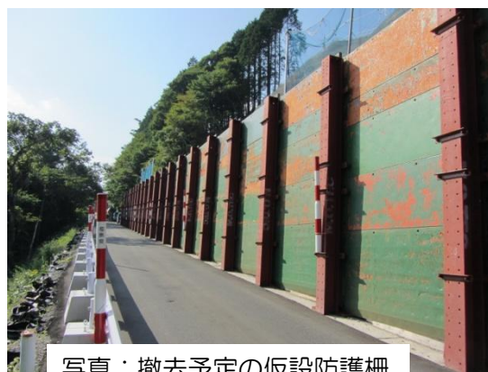
写真：撤去予定の仮設防護柵
