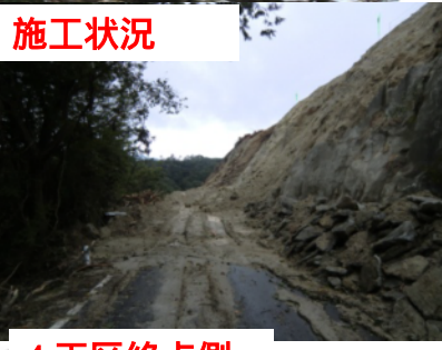
4工区終点側 (End of Zone 4)
