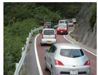
県道郡山湖南線 幅員狭小、線形不良
