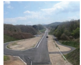
国道288号三春西バイパス整備中
