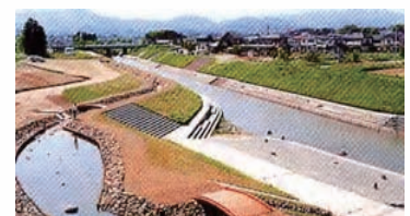
逢瀬川 整備済み状況
