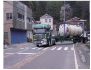
国道294号 道路線形不良、対向車線へ
