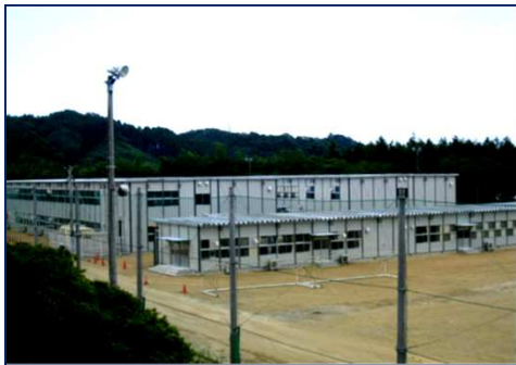
湯本高校の仮設校舎
