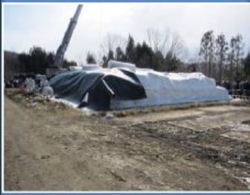
⑦ 上部遮水シート工
