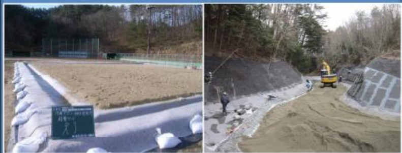
⑤ 保護土敷設
