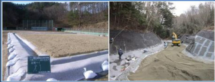
⑤ 保護土敷設
