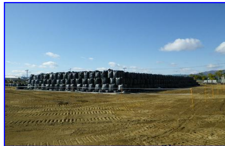
仮置場保管の例(地上保管) JAEA提供：除染モデル事業等の成果報告会 (2012.03.26)資料より
