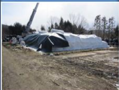
⑦ 上部遮水シート工
