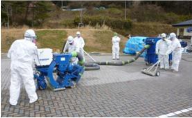
スチールブラストによる インターロッキング表面切削
