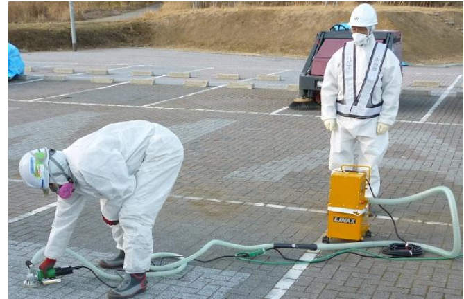
金属ブラシスイーパーによる インターロッキング表面切削
