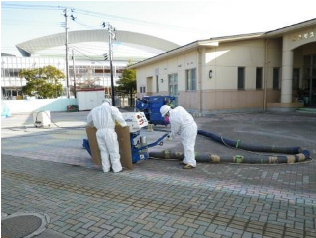
スチールブラストによる インターロッキング表面切削
