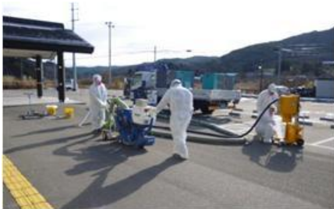
スチールブラストによる 舗装表面切削
