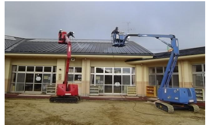
高圧水洗浄による屋根清掃
