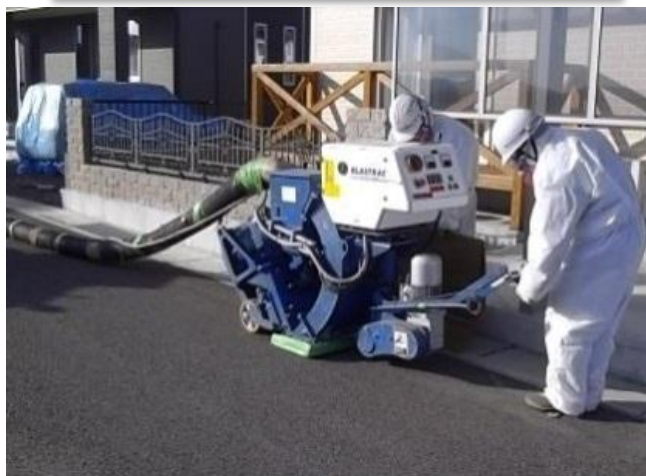
スチールブラストによる 舗装表面切削
