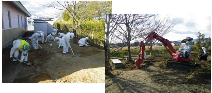
バックホウによる表土剥ぎ取り後 (砕石駐車場)
