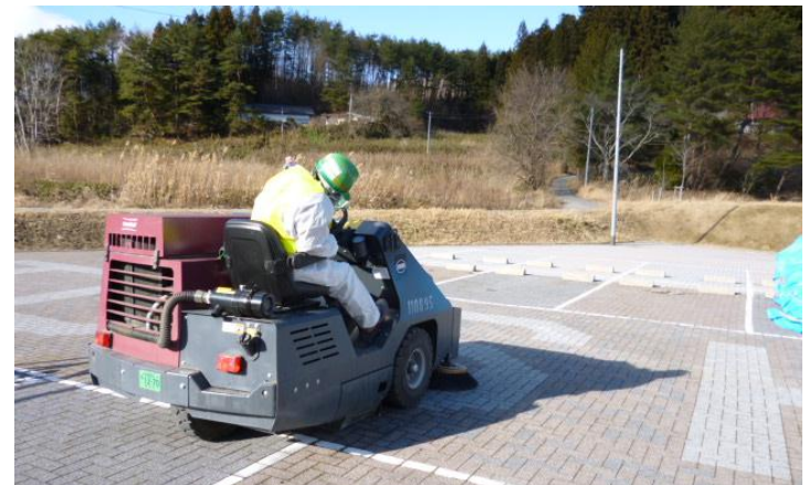
金属ブラシスイーパーによる インターロッキング表面切削
