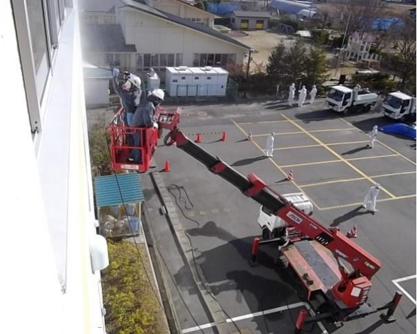
高圧水洗浄による壁洗浄
