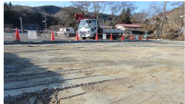
バックホウによる表土剥ぎ取り後 (砕石駐車場)
