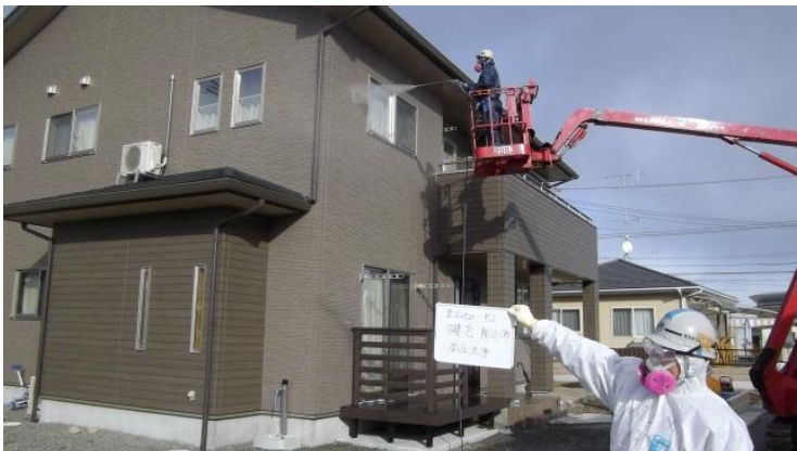
高圧水洗浄による壁洗浄
