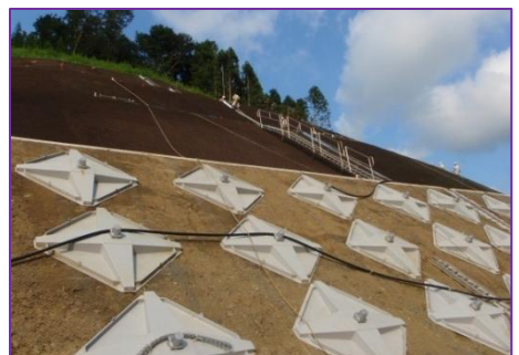
グラウンドアンカー工施工完了
