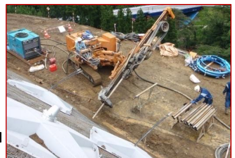
グラウンドアンカー工施工状況
