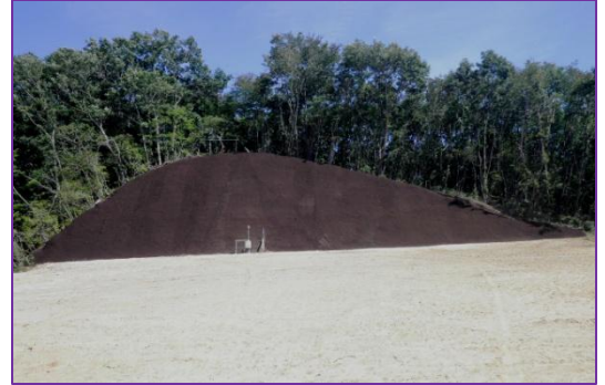
植生基材吹付工施工完了(6段目)
