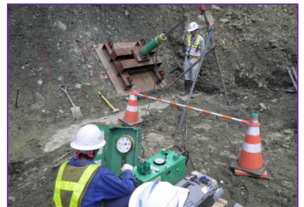
グラウンドアンカー工試験施工状況
