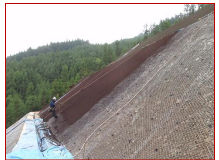
植生基材吹付工施工状況
