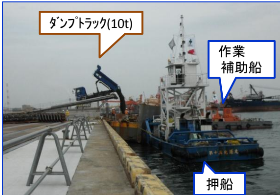
土運船への積み込み状況（埠頭側）
