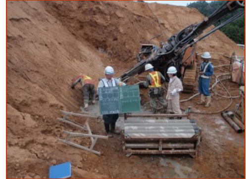
グラウンドアンカー工試験施工状況
