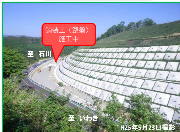
起点側（いわき側）より撮影
