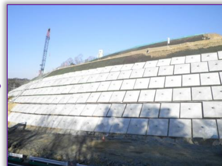
アンカー工施工完了
