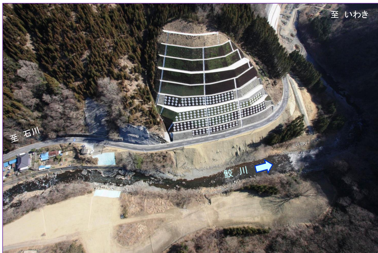
工事完了全景写真
