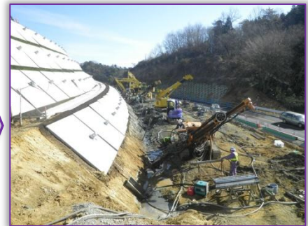
アンカー工削孔状況
