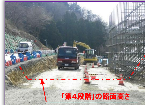
「第4段階」の路面高さの状況
