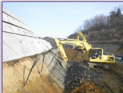
法面整形状況
