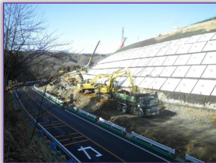
崩落土掘削積込状況
