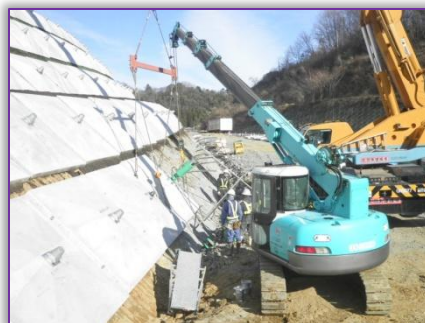
アンカー工緊張・定着状況
