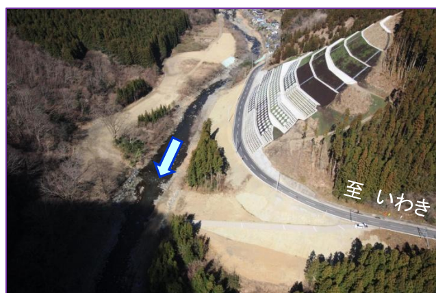
起点側の状況
