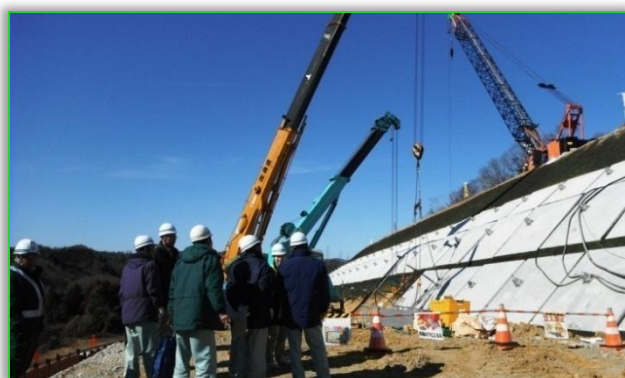
受圧板の設置状況
