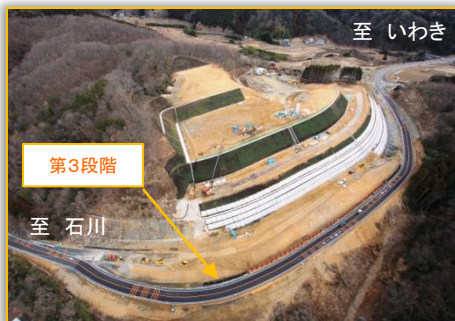
施工状況：「第3段階」の仮道工を使用（平成25年2月末）
