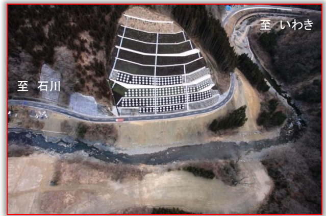
仮道工撤去完了（H25年2月）
