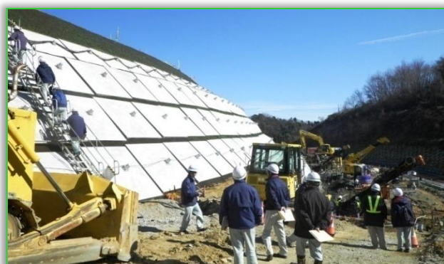
グラウトアツカ-施工状況
