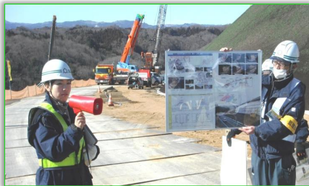
工事経過説明（中濱主査）
