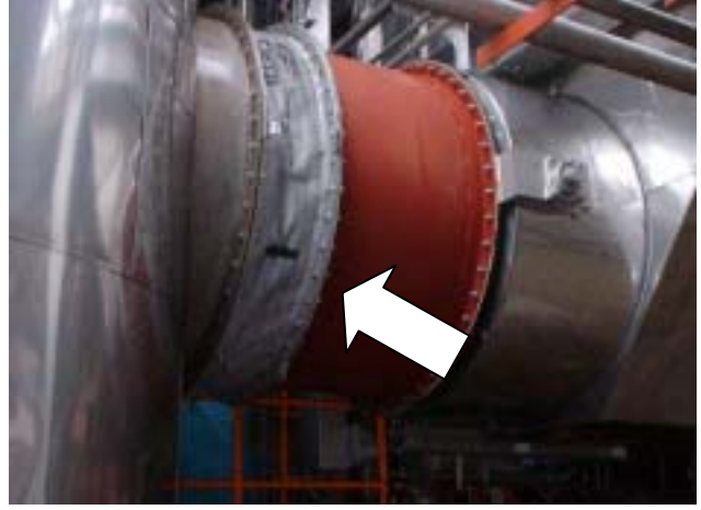
図 4-6-2 伸縮継手例
