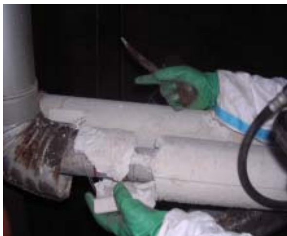
図 4-4-5 保温材等除去例
