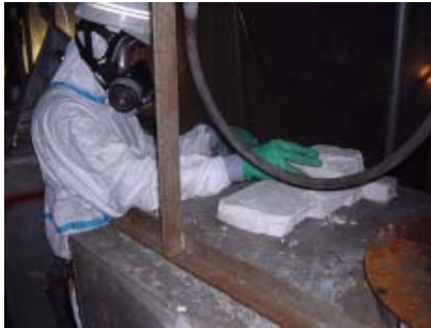
図 4-4-21 電気集じん器保温材等除去例(天井部)
