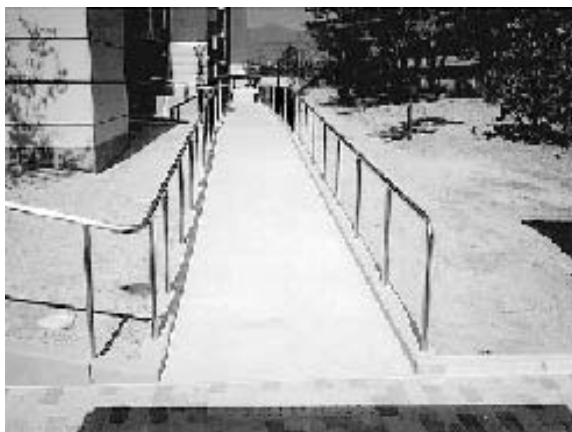
▲スロープを設けることで住戸の玄関まで段差なしで移動できます。
