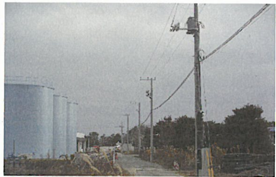
区間-E 配電線、照明設置状況(H8)
