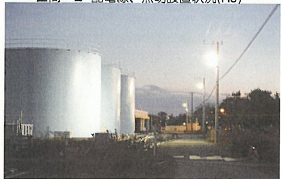
区間-E エリア照明点灯状況(H8)
