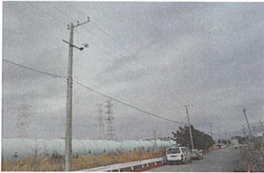
区間-D 配電線、照明設置状況(H1-D)
