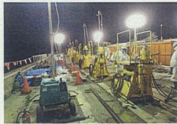
<地盤改良工事>
