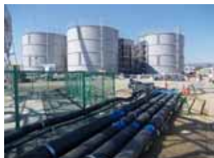
専用の配管・タンクを設置
