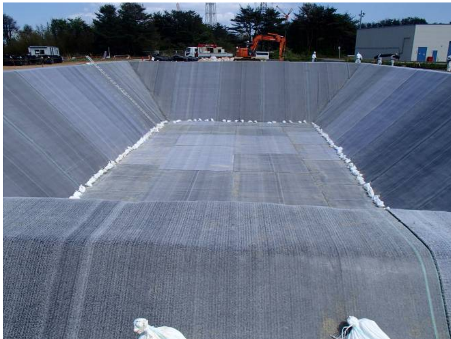
【ベントナイトシート敷設完了】
