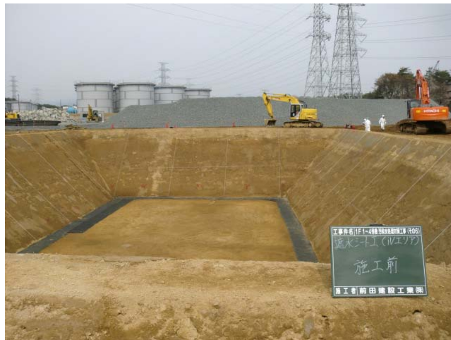
【掘削・地盤改良完了】
