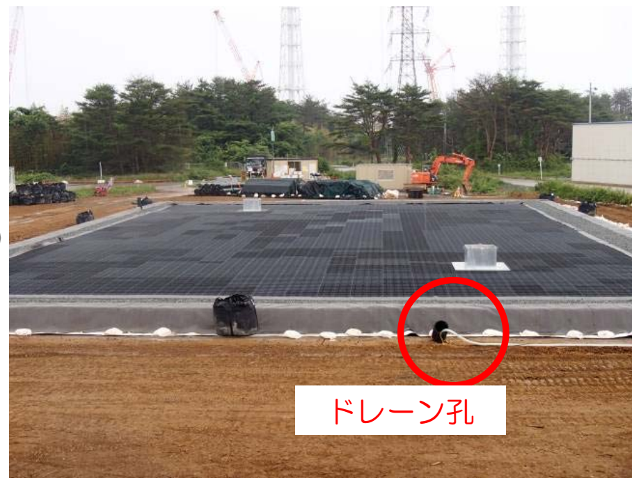
【貯水材組立完了】
