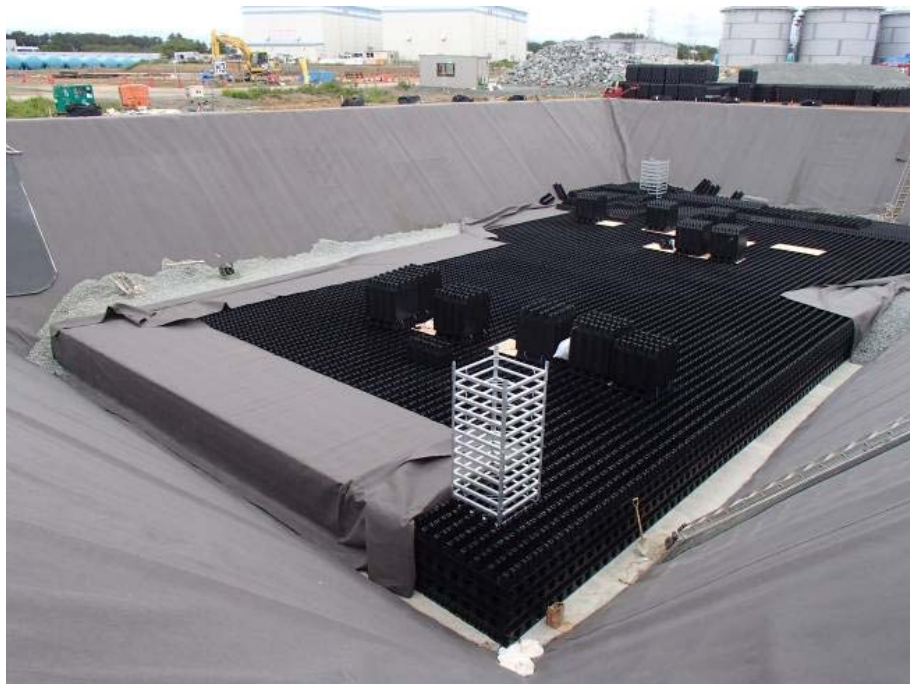
【貯水材組立状況】
