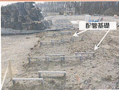
(B系統) 配管基礎設置状況
