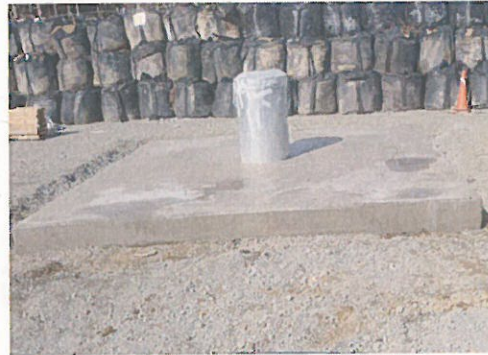
No.9揚水井（B系統）設置完了
