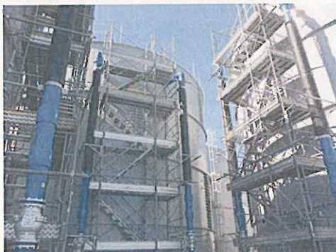
一時貯留タンク設置状況
