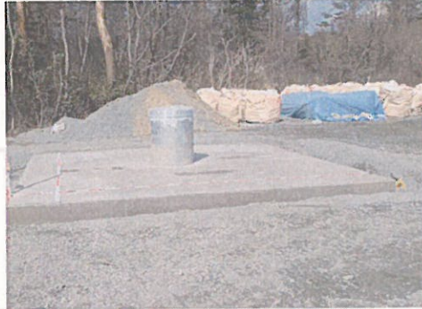
No.11揚水井（C系統）設置完了
