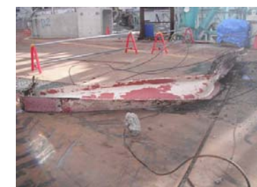
撤去後の様子
