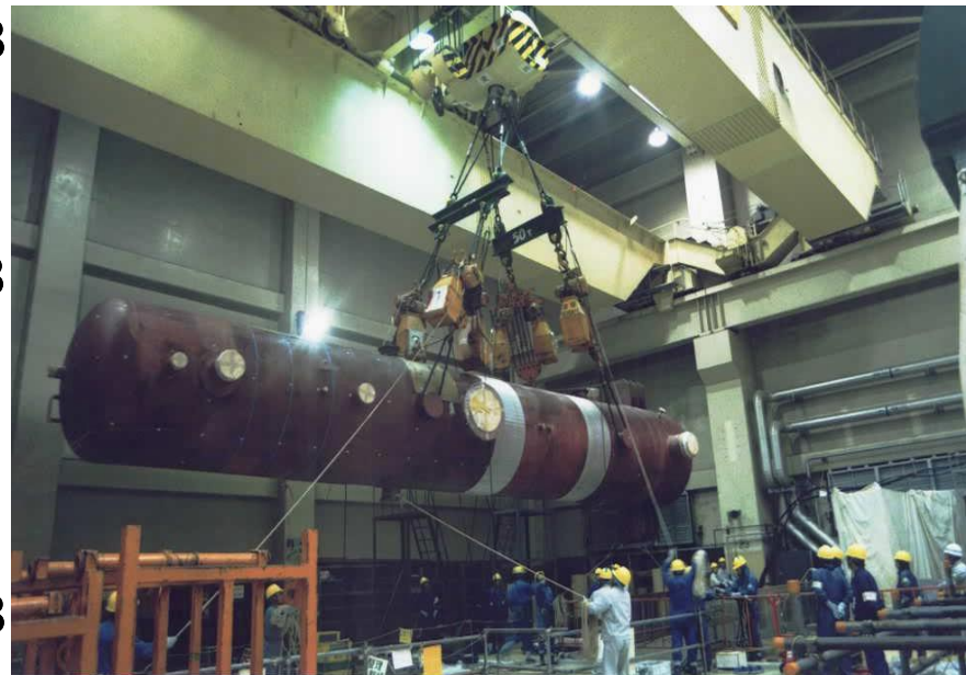
給水加熱器取替工事
