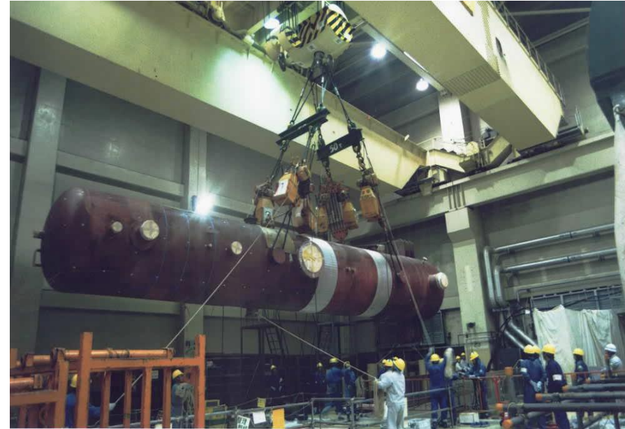
給水加熱器取替工事
