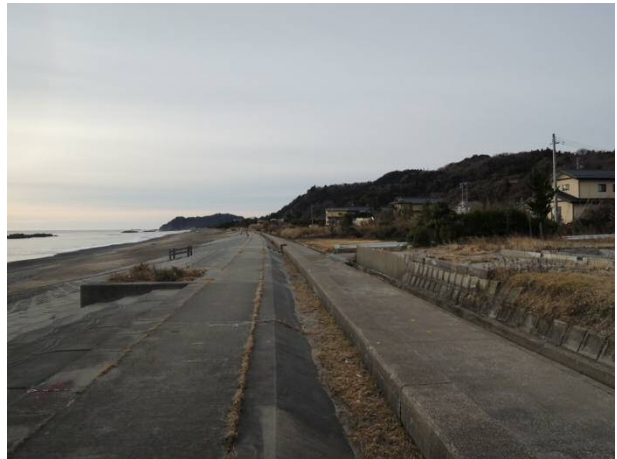
【工事前の写真】
