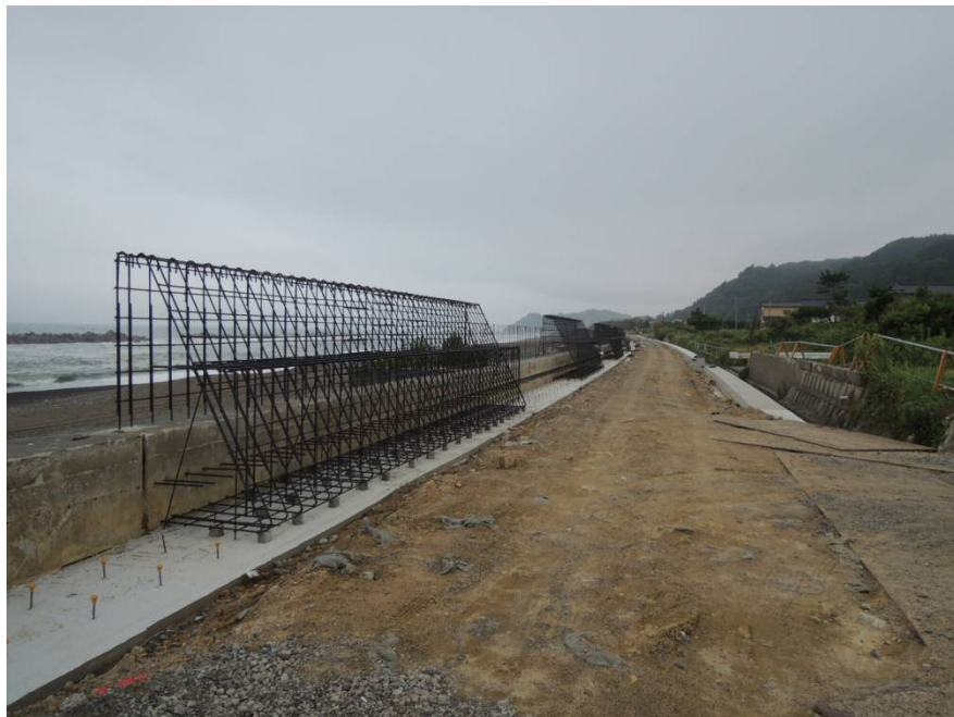
【工事中の写真】
