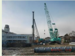
施工状況(杭打工)
