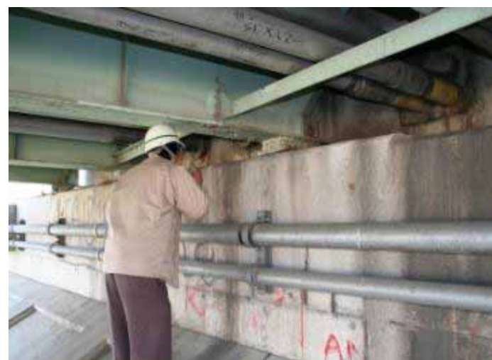
職員による橋梁点検(八木田橋)
