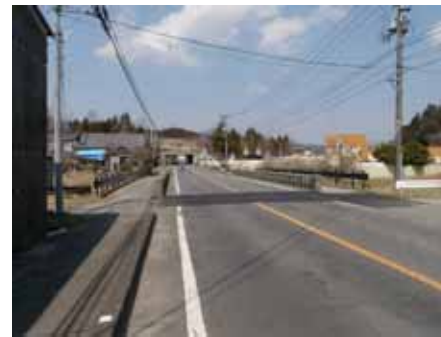
関場橋(いわき・上三坂・小野線)
