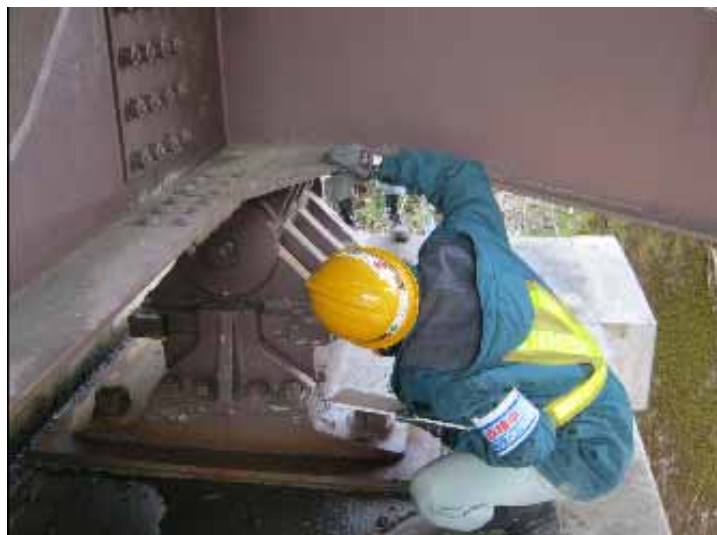
協定に基づく橋梁点検状況(福島県橋友会)
