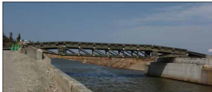
仮設橋完成状況
