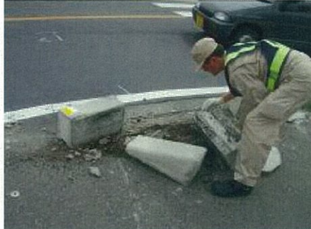
縁石補修作業
