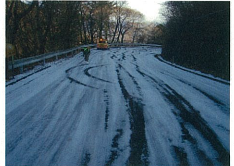
凍結防止剤散布作業
