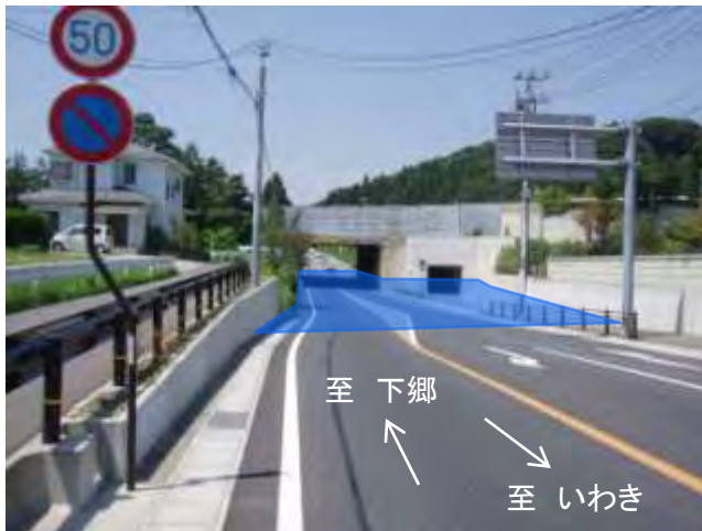
＜冠水時の状況＞
