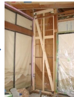
＜耐震改修事例：筋交い補強例＞
