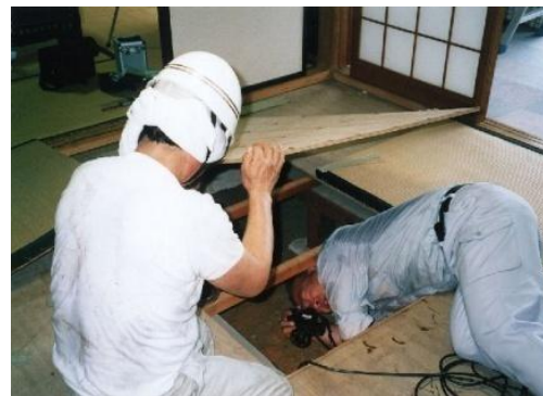
＜木造住宅耐震診断の実施＞
