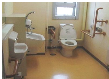
みんなのトイレを設置
