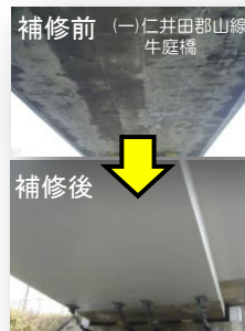
劣化した桁の補修により橋の長寿命化を図ります。
