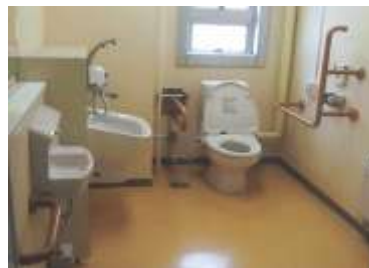
みんなのトイレを設置
