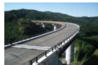
【国道289号 荷路夫バイパスの状況】
