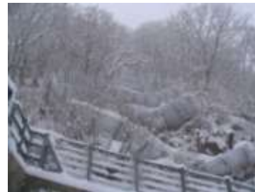
<喜多方市熱塩の雪崩を防止する整備事例(国道121号)>
