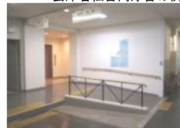
手すり・スロープで段差を解消
