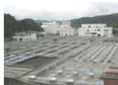
下水処理場：県中浄化センター
