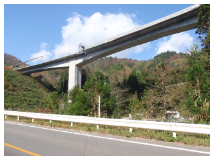
2 国道121号(大峠道路)
