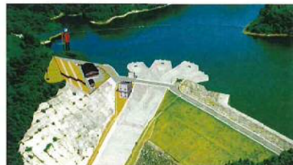
改築後：洪水調節機能あり
