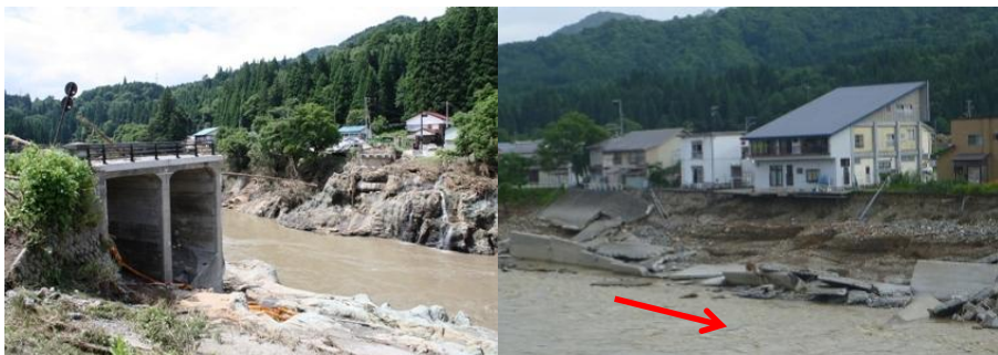
国道252号二本木橋（金山町）
