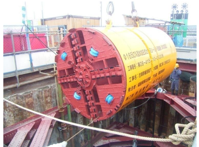
推進機投入状況
