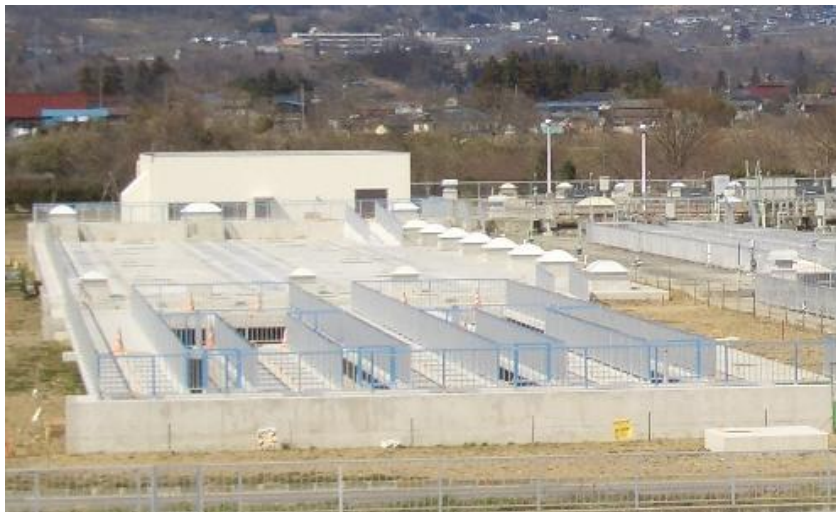
水処理施設(2系列1、2池・土木)
