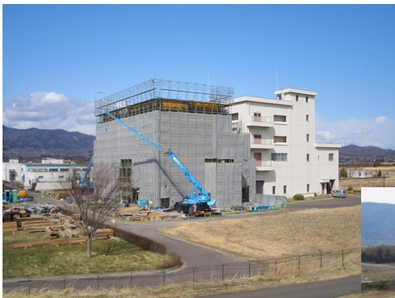
◀ 汚泥処理棟建設中
