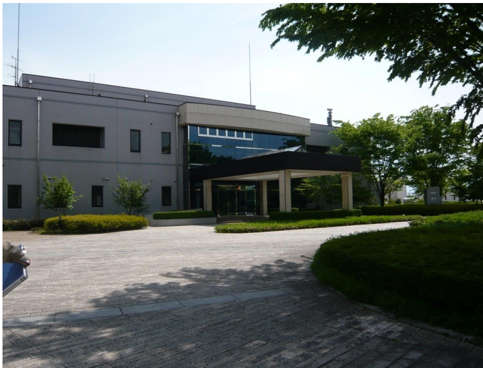
▲ 県北浄化センター管理棟
