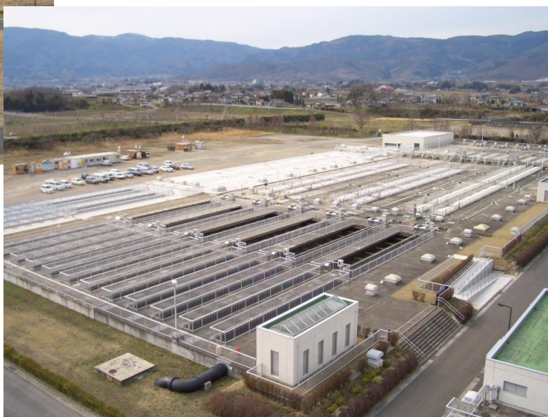
水処理施設(土木)建設中 ▶
