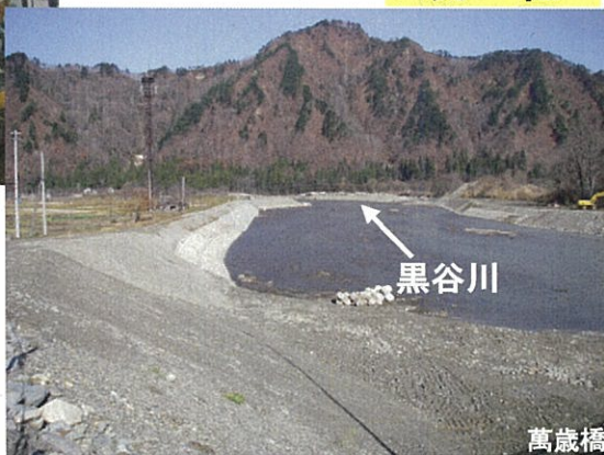
萬歳橋下流 （只見町大字黒谷地内） 自然石護岸工事が完了。 （平成24年12月3日撮影）
