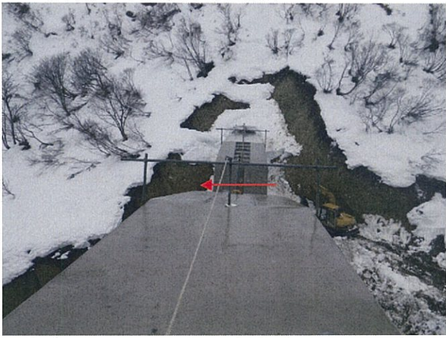
本堤(H=14.5m L=58.0m)コンクリート打設完了 (平成24年12月18日撮影)
