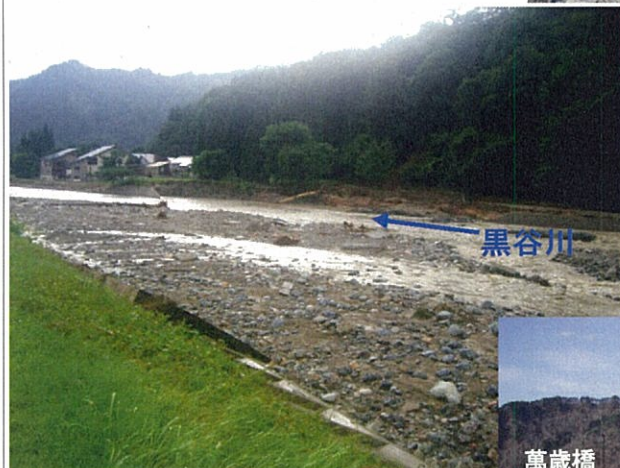
萬歳橋上流 （只見町大字黒谷地内） 自然石護岸工事が完了。 （平成24年12月3日撮影）
