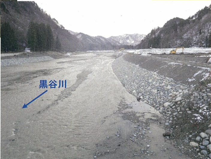
峯沢橋直上流 （只見町大字黒谷地内） 自然石護岸工事が完了。 （平成24年12月6日撮影）
