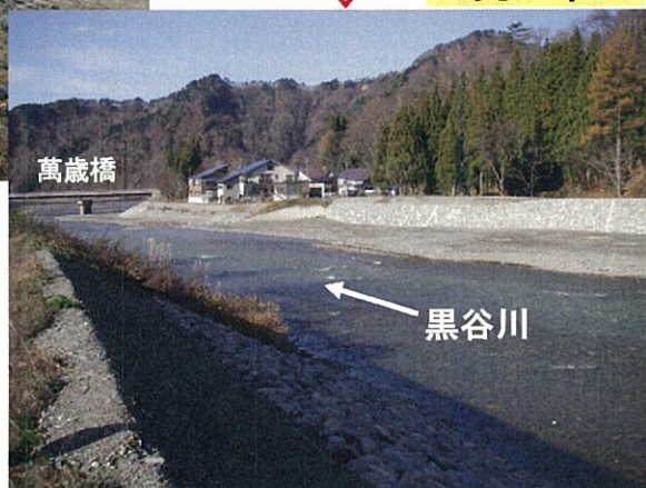
萬歳橋上流 （只見町大字黒谷地内） 自然石護岸工事が完了。 （平成24年12月3日撮影）
