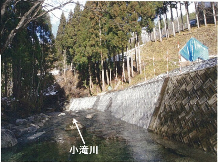
本堤(H=14.5m L=58.0m)コンクリート打設完了 (平成24年12月18日撮影)
