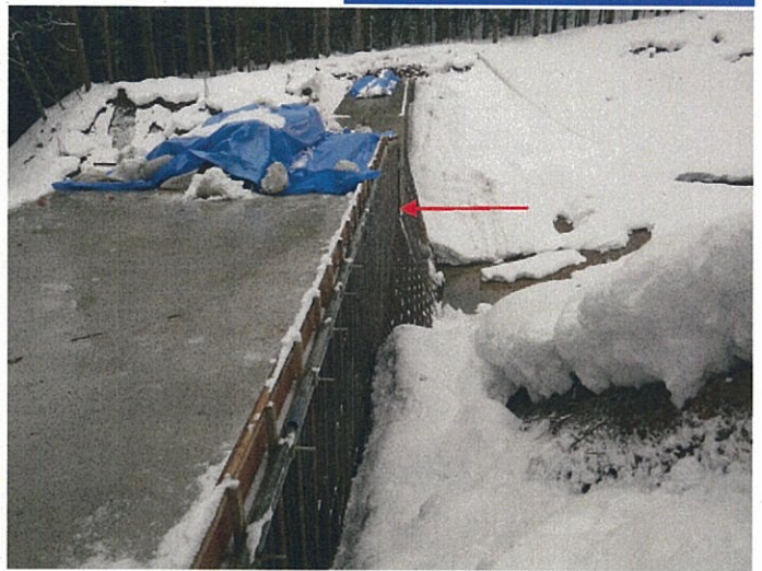
砂防ソイルセメント工法(INSEM工法)による本堤完了(H=11.0m L=50.5m)(平成24年12月25日撮影)
