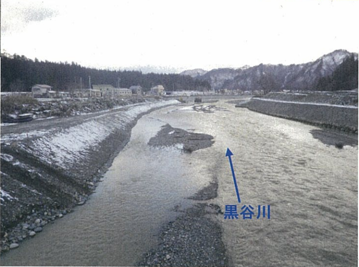
峯沢橋直下流 （只見町大字黒谷地内） 護岸工事が完了。 （平成24年12月6日撮影）
