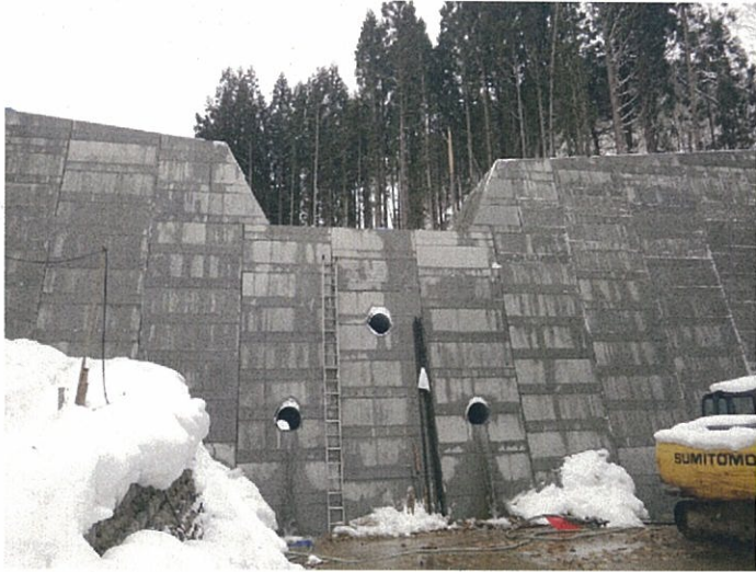
砂防ソイルセメント工法(INSEM工法)による本堤完了(H=11.0m L=50.5m)(平成24年12月25日撮影)
