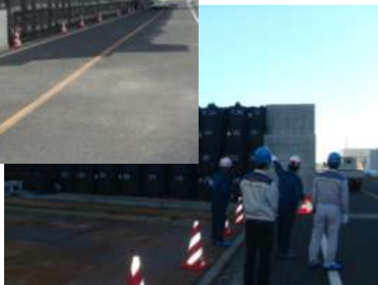
津波対策としての土嚢の積み上げ状況の確認
