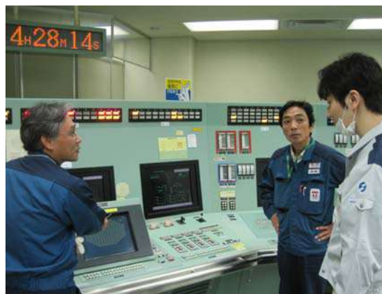
中央制御室への立入検査による原子炉の未臨界確認
