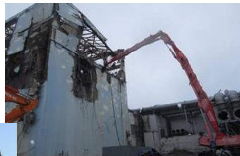
4号機瓦礫撤去作業
