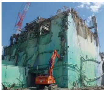
3号機瓦礫撤去作業 9/10時点
