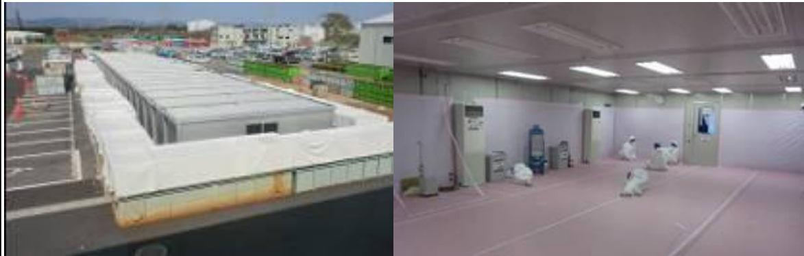
現場休憩施設外観(左)と内観(右)
