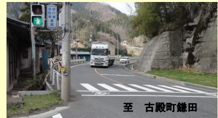
【長光地工区 現道状況】
