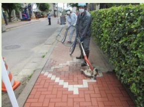
高圧洗浄除染の様子 (高倉団地)
