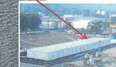
廃スラッジ一時保管施設
