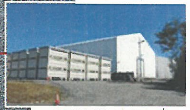
瓦礫保管テント-収納容器
