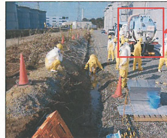
吸引車による漏えい物回収作業の様子 「RO濃縮水移送ホースからの漏えい発生時」
