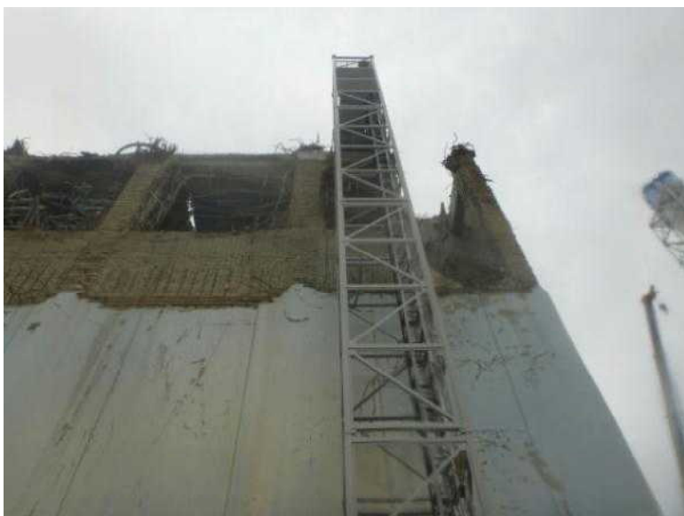
4号機建屋西側に設置された 昇降機（エレベーター）。 これにより作業員が仮設足場 階段を昇る負担が軽減され、 作業環境が改善された。
