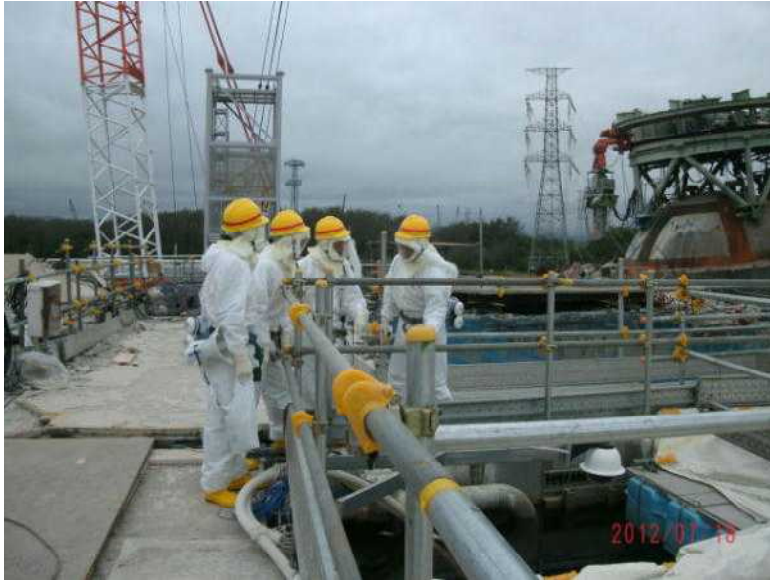
使用済燃料プール水面および 水位監視カメラの確認
