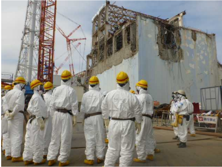
4号機原子炉建屋の状況
